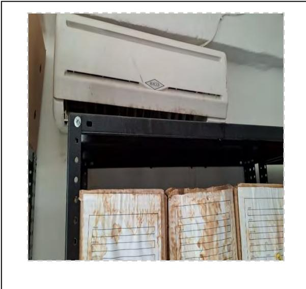
fotografía N°5 Sistema de Ventilación, aire acondicionado con goteo sobre estantería con documentos Año:2024
